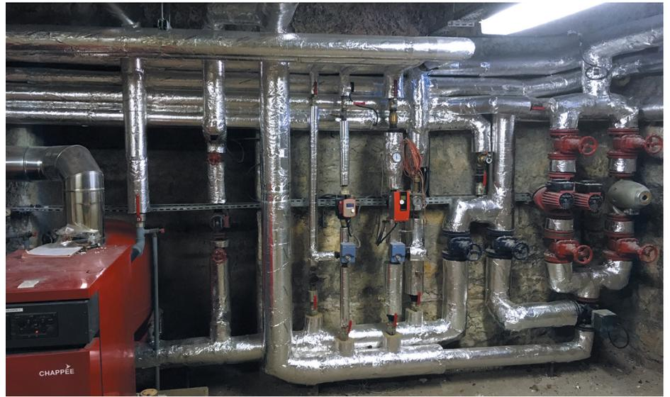
La Ville a engagé un programme de calorifugeage des tuyaux, permettant de diviser les déperditions de chaleur par six.
