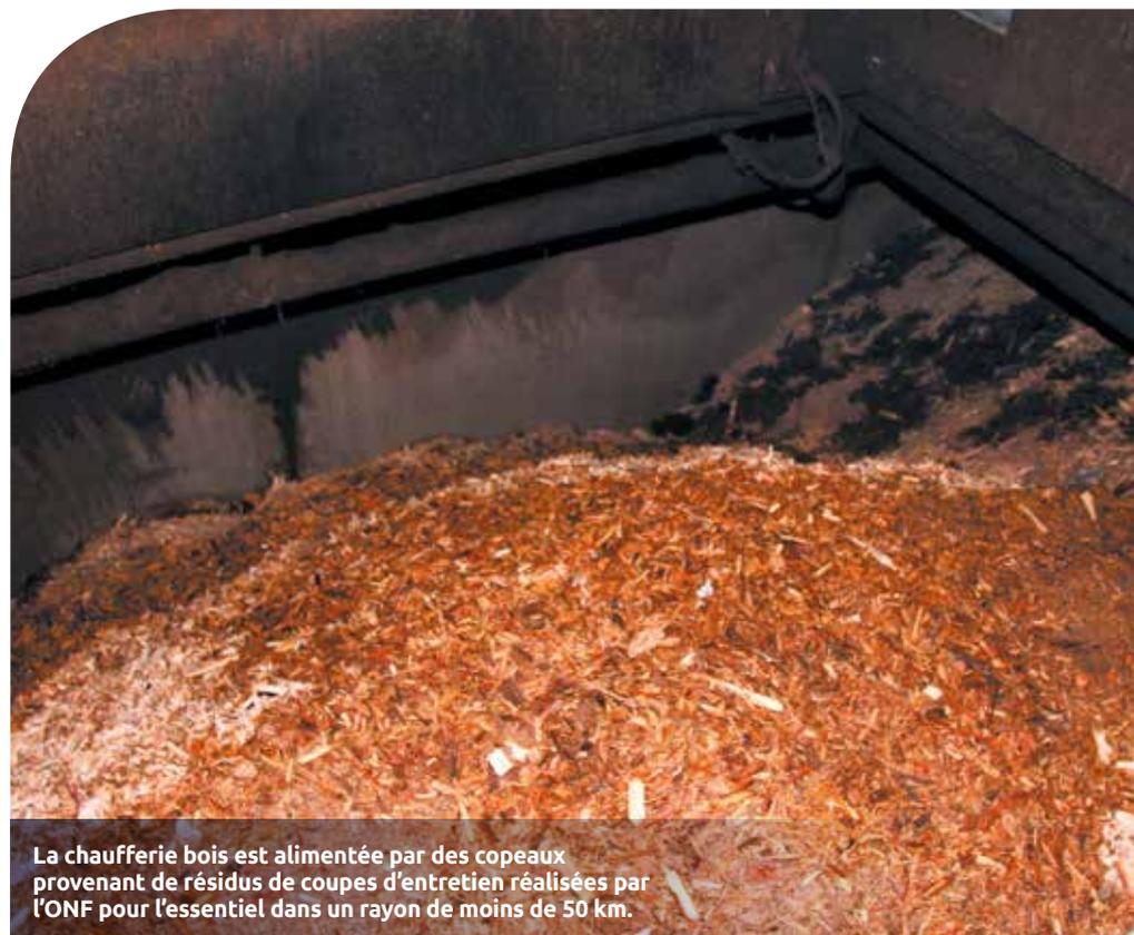
La chaufferie bois est alimentée par des copeaux provenant de résidus de coupes d'entretien réalisées par l'ONF pour l'essentiel dans un rayon de moins de 50 km.
