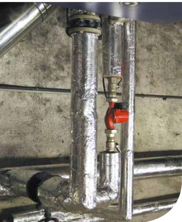
canalisations d'eau chaude de chauffage. 5 kilomètres de tuyaux ont été isolés, permettant de diviser les déperditions de chaleur par six, pour une économie estimée à 19 000 € par an. D'un montant de 141 700 €, cette opération n'a rien coûté aux contribuables puisqu'elle a été financée par des fournisseurs d'énergie dans le cadre des certificats d'économie d'énergie (CEE).
