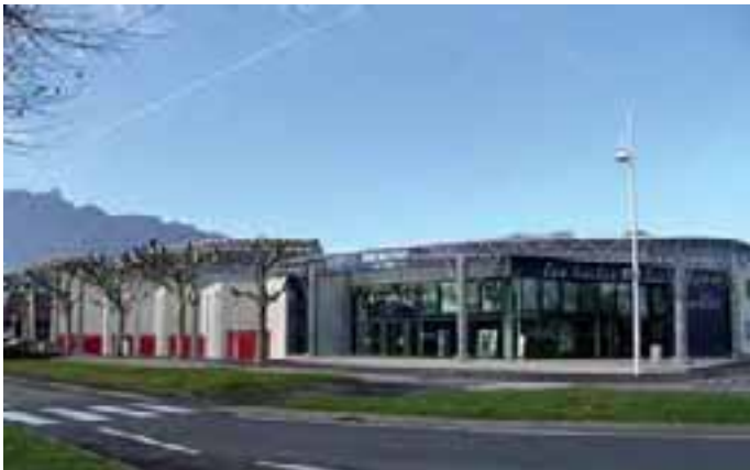
Le complexe de 8 salles de cinéma « les Toiles du Lac »
