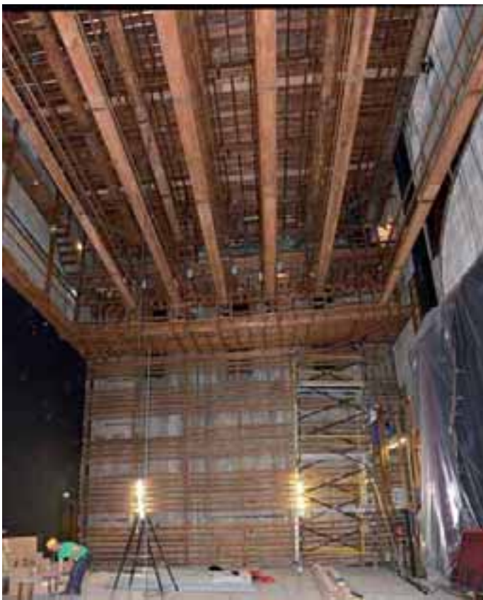
Réhabilitation en cours de la scène du théâtre
