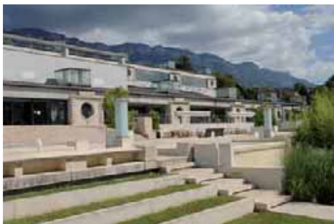
La façade des thermes Chevalley
