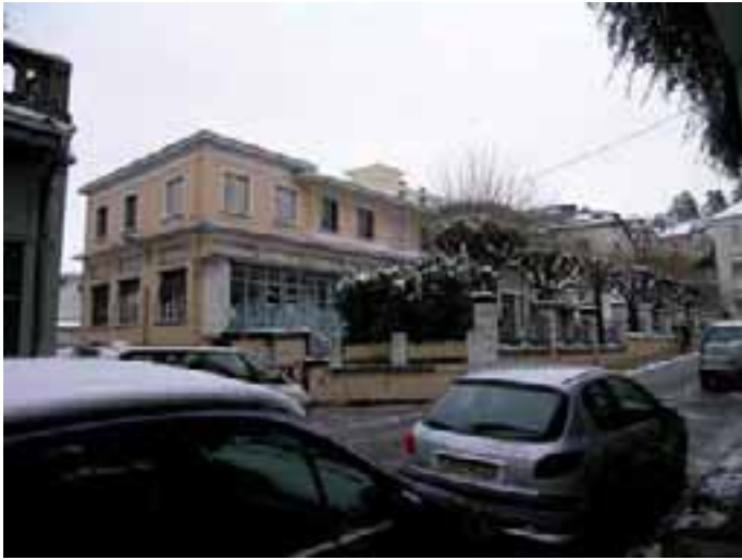
L'école du Centre avant travaux
