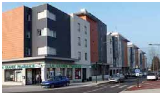
Les nouvelles constructions remplaçant les tours.
