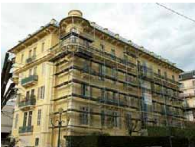
Rénovation de la façade de l'immeuble «Les Ambassadeurs»
