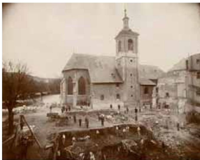
Démolition du quartier de l'ancienne église
