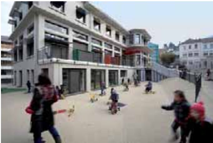
L'école du Centre après travaux
