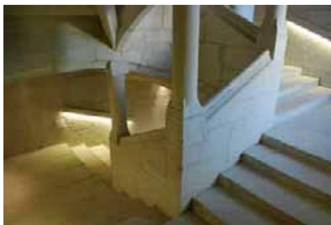
L'escalier de la mairie Photo Service communication / Mairie d'Aix-les-Bains
