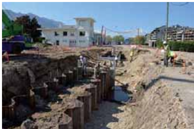
Travaux de rénovation de l'embouchure du Tillet
