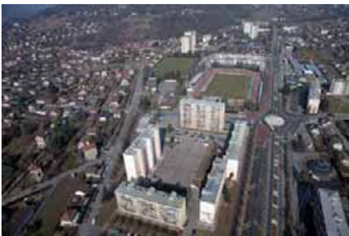
Les quartiers de Franklin-Roosevelt et de Lafin en cours de rénovation
