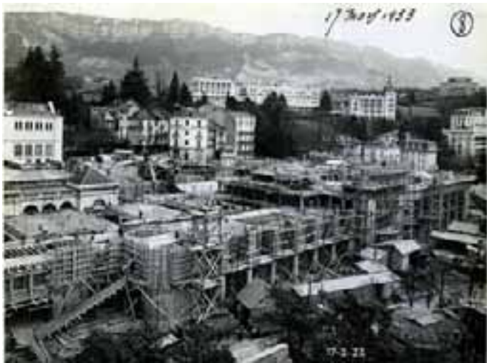
Construction des thermes Pétiaux (1933)
