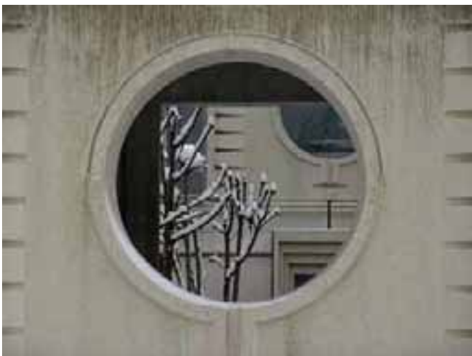
Détail de l'architecture des thermes Chevalley
