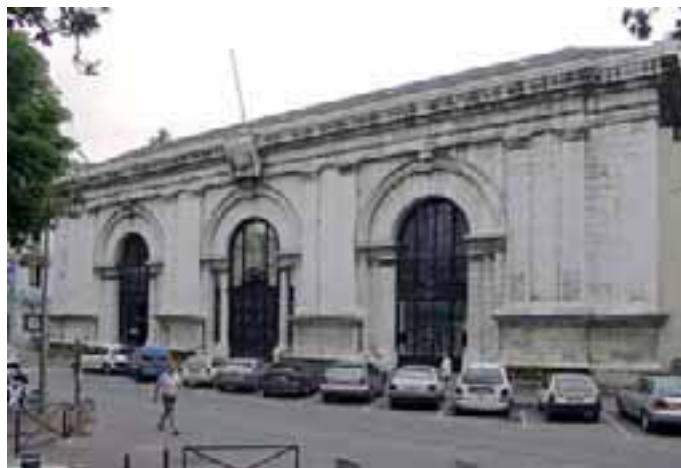
Façade des thermes Pellegrini
