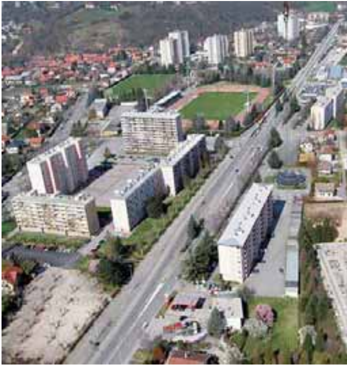
Les quartiers de Franklin-Roosevelt et de Lafin avant rénovation
