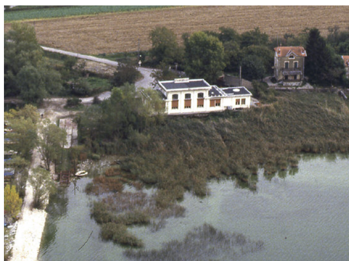
^ L'ancienne station de pompage. Vue aérienne, vers 1990. (AC Aix-les-Bains)
