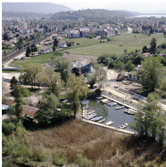
^ L'ancienne station de pompage (à droite) et la nouvelle, en construction (à gauche), 1994. (AC Aix-les-Bains)
