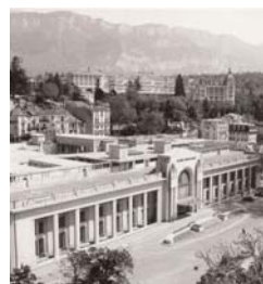
Façade des thermes Pétriaux et vue sur les toits. Photo Karquel, vers 1940.
