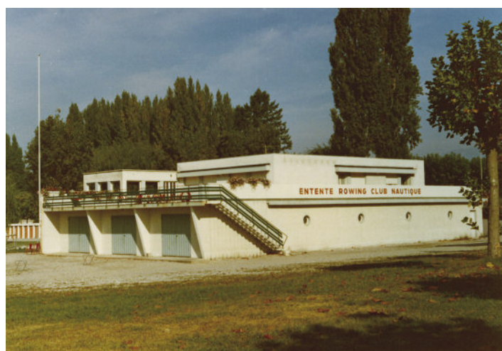
^ Le garage du Rowing, vers 1970. (AC Aix-les-Bains)
